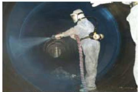
Water transfer conduits
